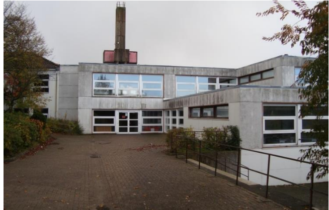
Oberschule Osterholz-Scharmbeck (Bestandsgebäude)
